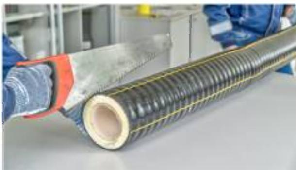
**5. Удалить полиэтиленовую оболочку с торца ГПИ трубы.**
