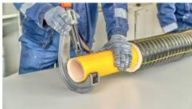
**8. На подготовленный торец ГПИ трубы необходимо надеть термоусаживаемую заглушку изоляции (ТЗИ). Защитная пленка клеевого слоя ТЗИ должна быть удалена непосредственно перед её термоусадкой.**
