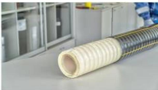
**6. Аккуратно, при помощи молотка или ножа удалить теплоизоляционный слой. Поверхность напорной трубы не должна быть повреждена.**
