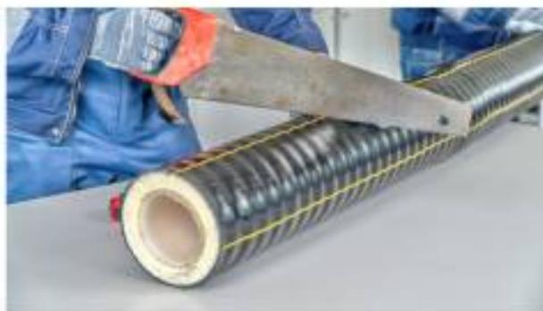
**4. Надрезать полиэтиленовую оболочку по направлению от торца трубы к ранее сделанному поперечному надрезу.**
